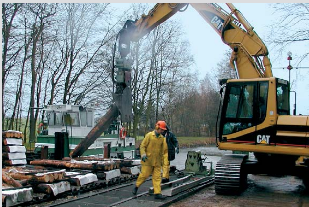
Ufersicherungsarbeiten in Holzpfahlpaketbauweise
